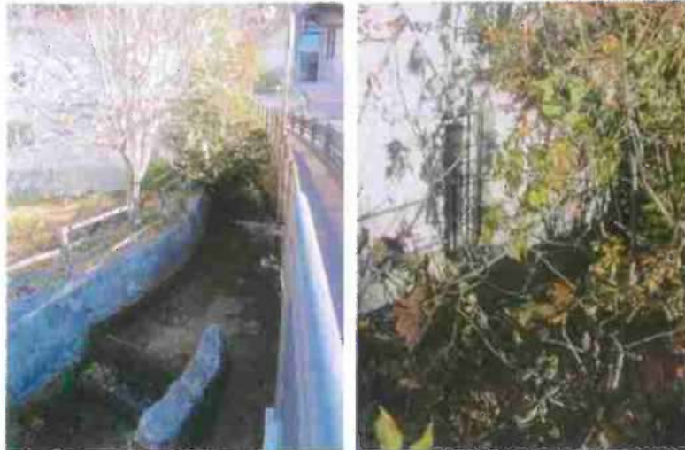
Roggia –esistente sul lato sud della casa – presenza di cespugli
